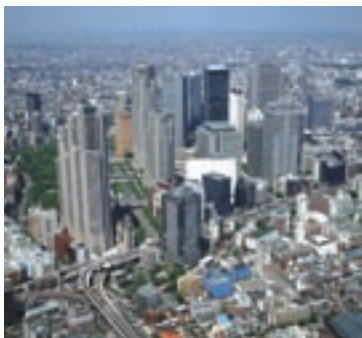
采用区域集中供冷供热系统的日本新宿地区
